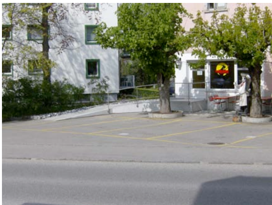
Aegerten: Neuer hindernisfreier Zugang Restaurant „La Strega“ kombiniert mit Einbau Fumoir
